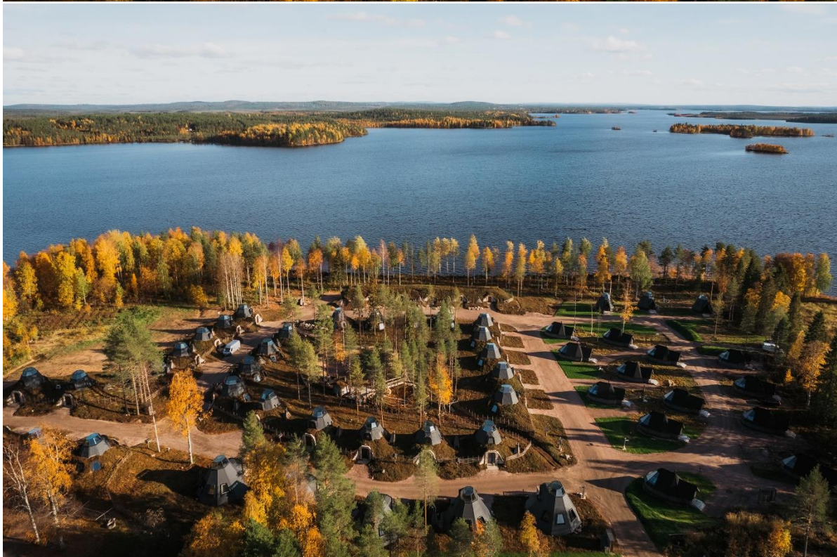
Kuva 7. Apukka Resortin rakennuksia VT 4 suunnalta.
